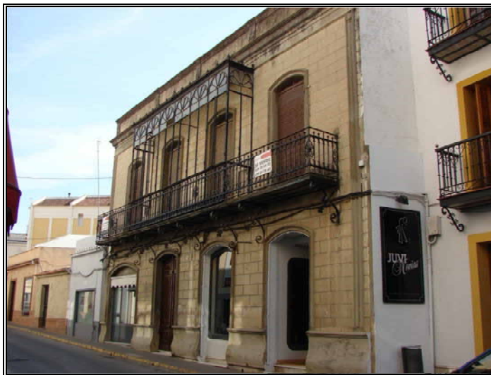
Vivienda Calle Real 26.
